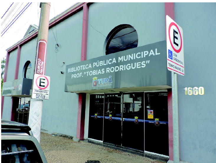
Biblioteca municipal funciona na Tamoios, ao lado da PM e do teatro
